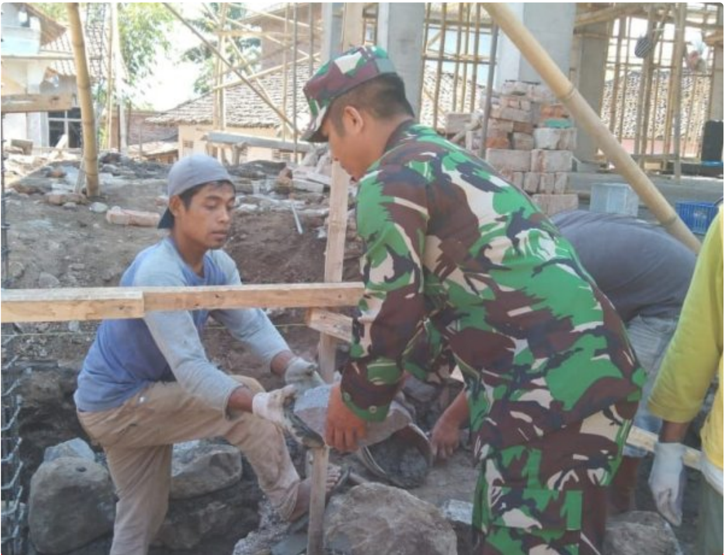
Serda Nasikin bantu pemasangan batu pondasi masjid
